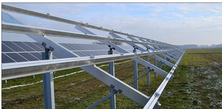
Fot. 9. Konstrukcja przeznaczona do posadowienia paneli fotowoltaicznych (http://www.planergia.pl/)
