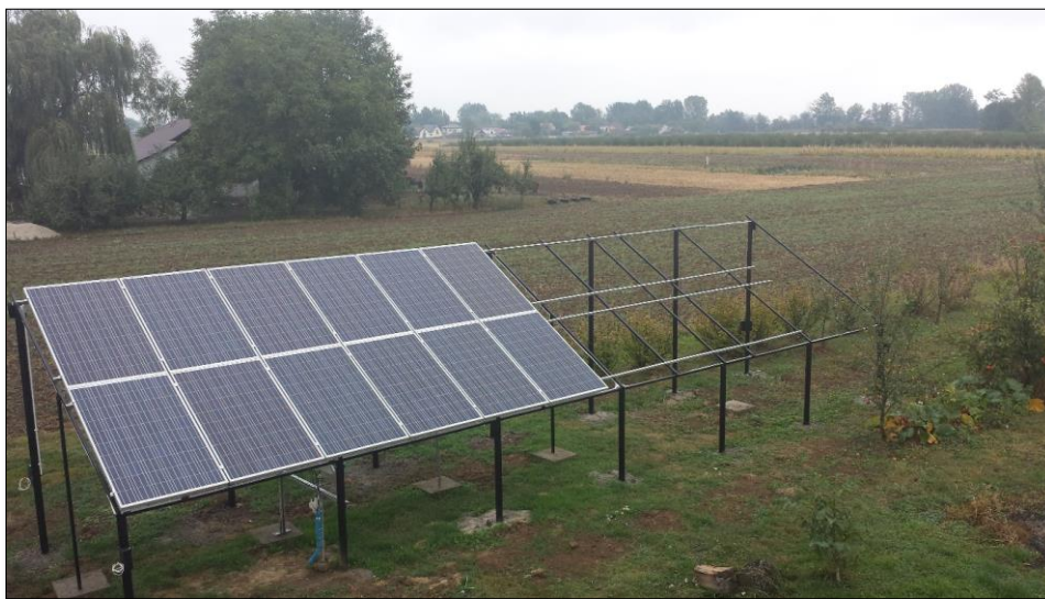
Fot. 1. Konstrukcja stołu z panelami fotowoltaicznymi ( www.elektroda.pl )
