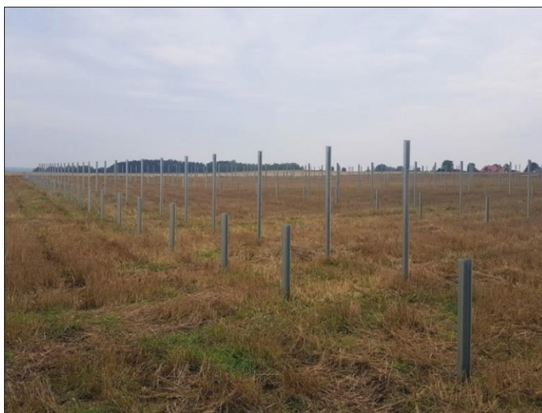
Fot. 7. Profile metalowe: podstawowy element konstrukcji ( https://www.energy5.pl/ )
