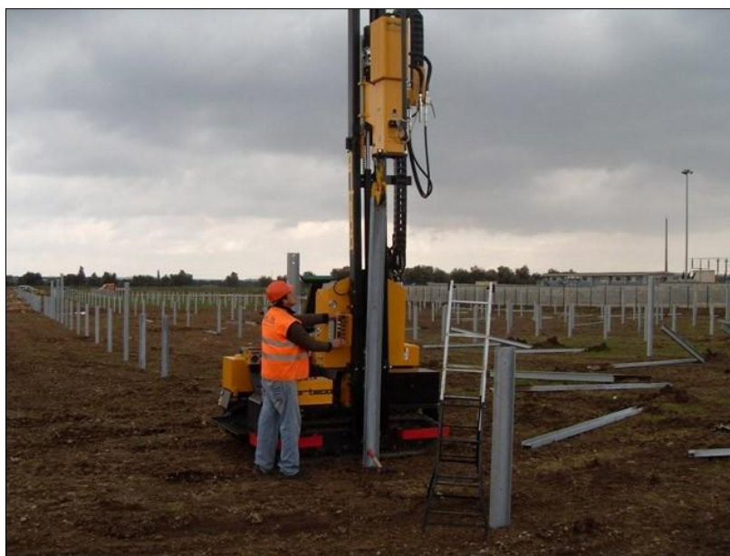
Fot. 8. Montaż profili za pomocą kufara (http://www.liftonpolska.pl/)
