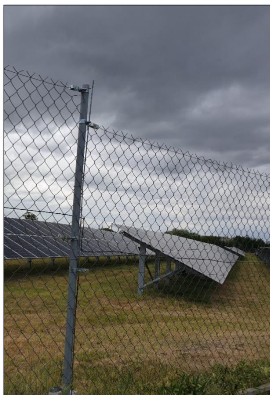
Fot. 6. Sposób montażu paneli fotowoltaicznych na stelażach wbijanych bezpośrednio do gruntu
